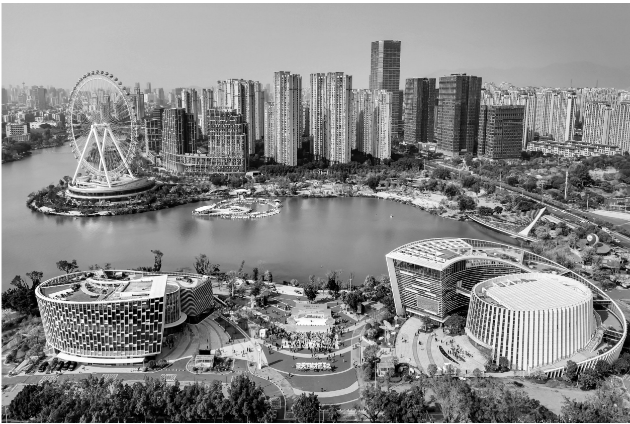
12月22日，福建省福州市晋安区晋安湖畔，福州市文化馆新馆、福州市少年儿童图书馆新馆正式开放，两座曲线形建筑与整个晋安湖公园浑然一体。看演出、学才艺、逛展览、品非遗……当天，两馆推出一系列开馆活动，让市民尽情享受文化大餐。图为两个文化场馆及晋安湖远景。 谢贵明 摄
