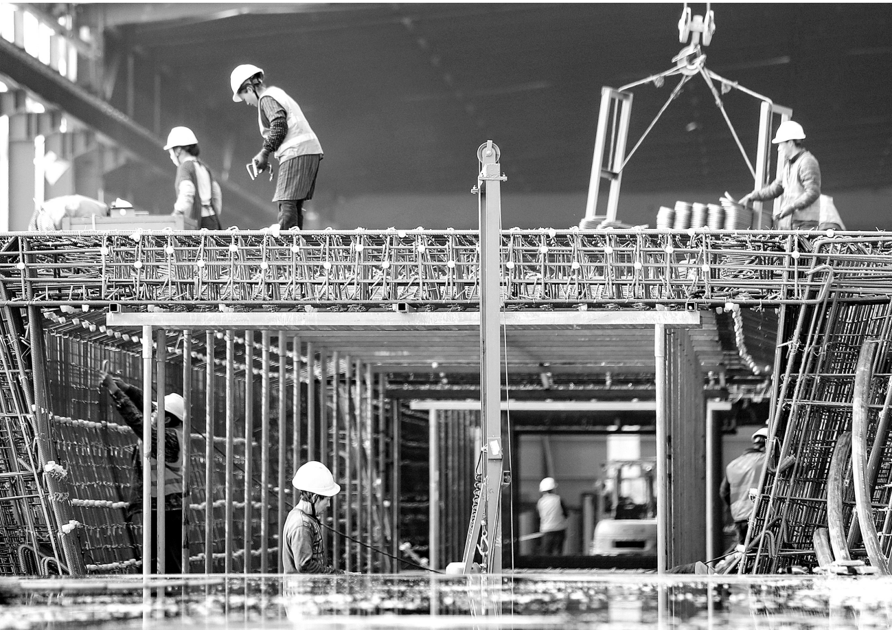
春节之后，由中铁十局承建的西渝高铁四川广安东站制梁场正式投入箱梁浇筑，同时，进入广安东站制梁场的四线桥也在有序施工、加紧建设。图为2月25日，正在有序施工的华蓥市明月镇境内紧邻西渝高铁广安东站制梁场的四线桥。邱海鹰 韦毅 摄
