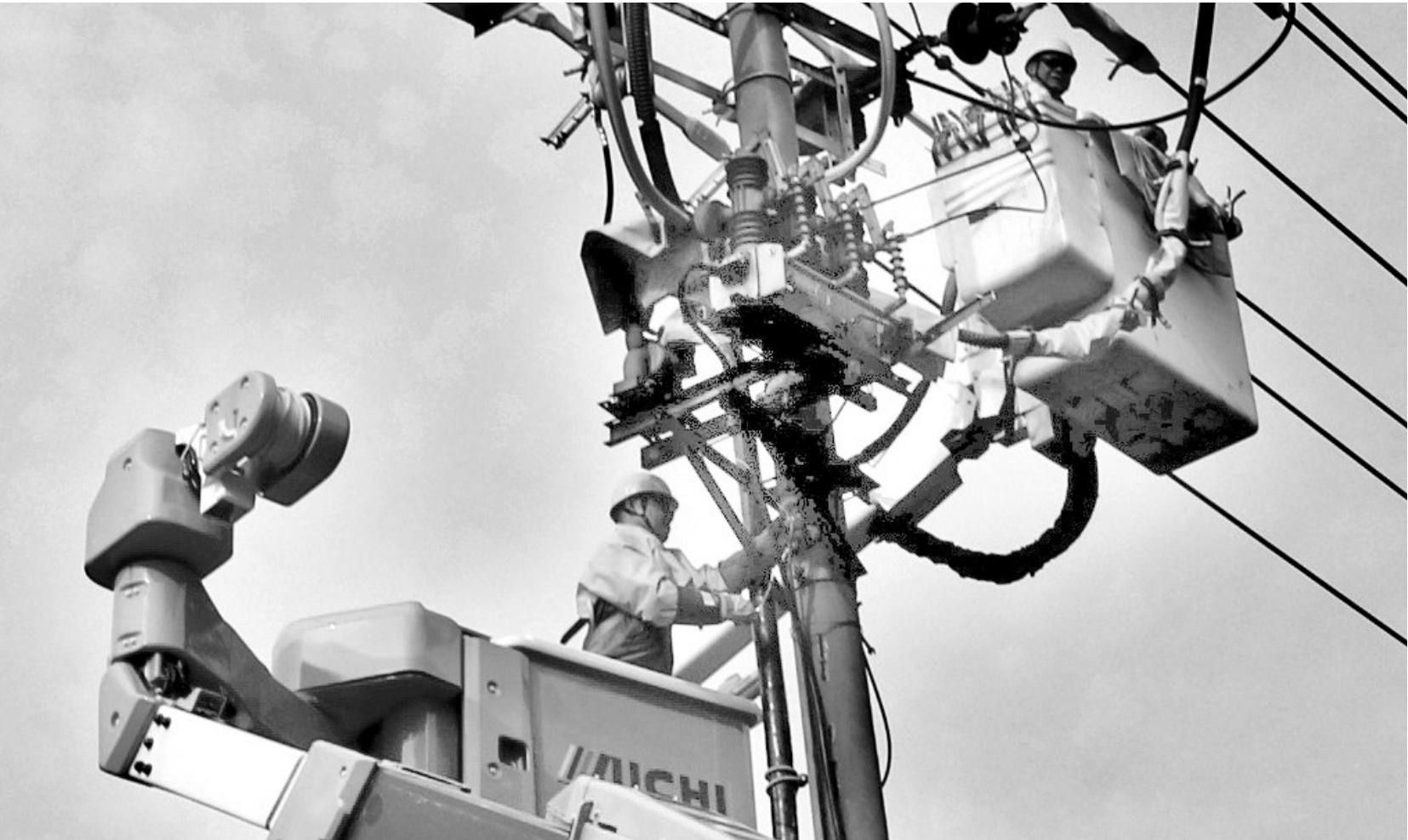
连日来，江西省新余市持续高温天气，用电负荷不断攀升，电力供应迎来高峰“烤”验。国网新余供电公司不断完善迎峰度夏负荷管理，优化电网调度运行方式，加强电网运维保供，全方位保障夏季用电高峰期间电力供应可靠。图为7月17日，在新余市渝水区下村镇，电力工人在对电力设施进行升级改造。 廖海金 摄
